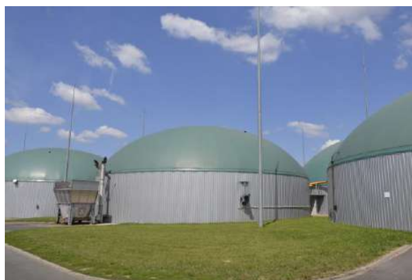
Rysunek 3. Biogazownia w Przemysławiu
